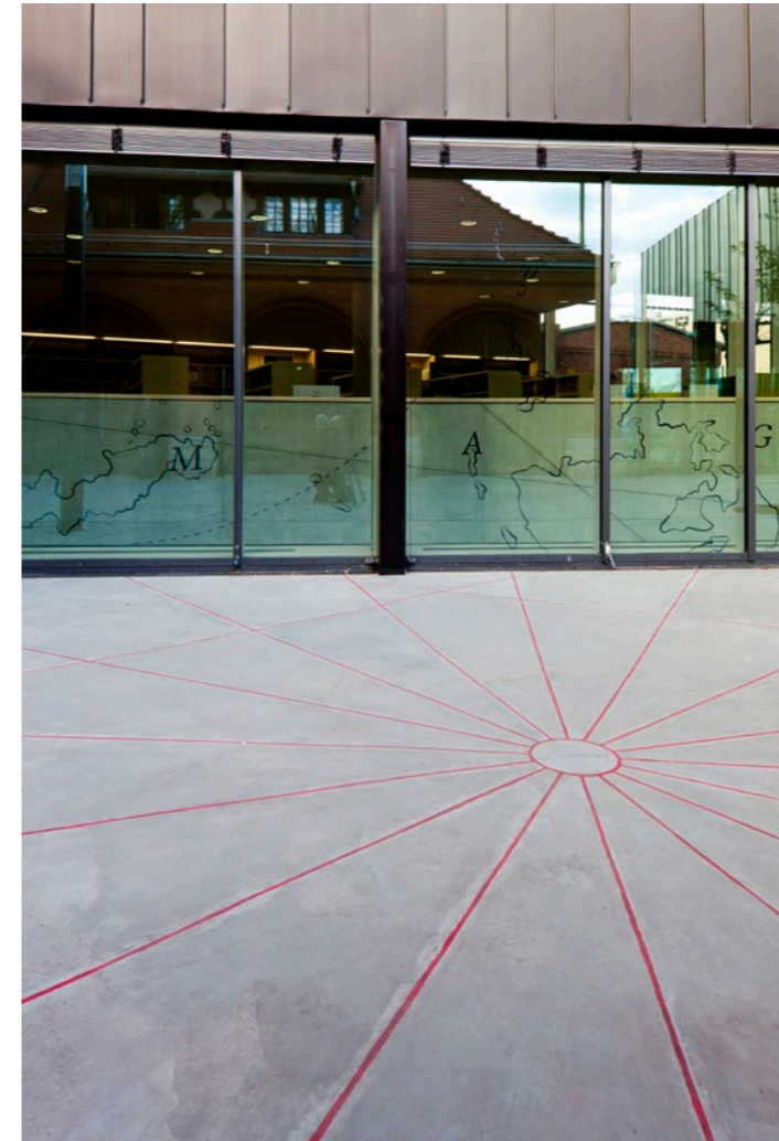
gefräste, farbig verfüllte Fugen im Innenhof, lackierte Outlinemotive auf Glasfassade, Klebefolien auf Brüstung
