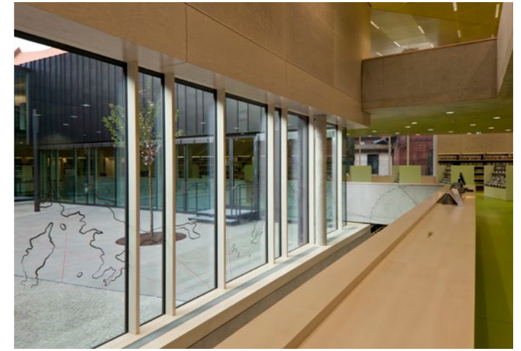
gefräste, farbig verfüllte Fugen im Innenhof, lackierte Outlinemotive auf Glasfassade, Klebefolien auf Brüstung
